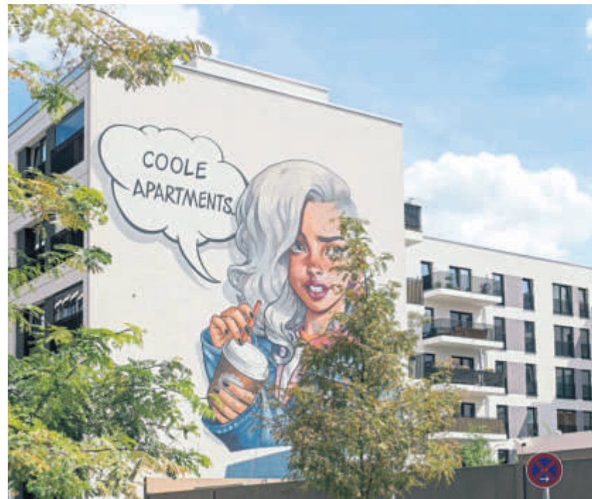
Vorzeigeprojekt an der Heisestraße mit 3.000 Wohnungen
