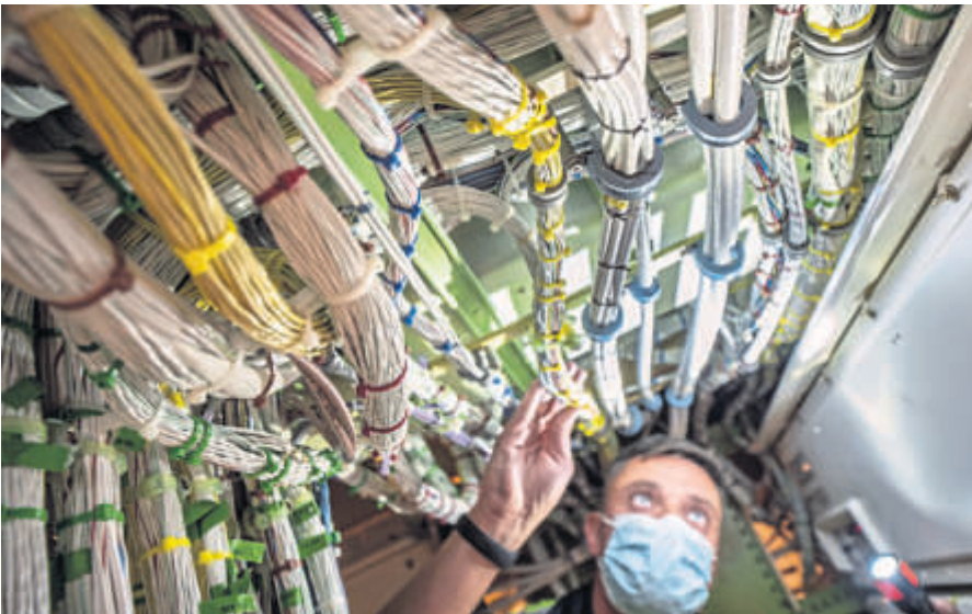
Ein Fluggerät-Elektroniker überprüft in der Lufthansa-Werft am Frankfurter Flughafen Kabelstränge im „Herz“ einer Boeing, dem sogenannten Main Equipment Center. Bild: Frank Rumpenhorst/dpa-mag
