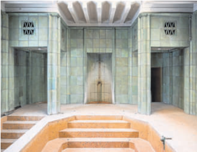
Kaltwasserbecken mit Dusche.
