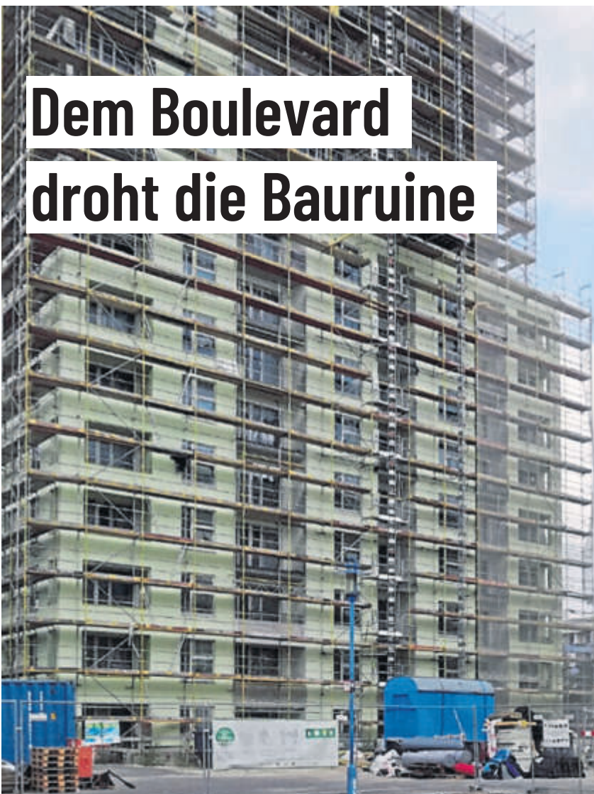
Insbesondere die Fertigstellung des Hochhauses steht auf wackligen Füßen.
