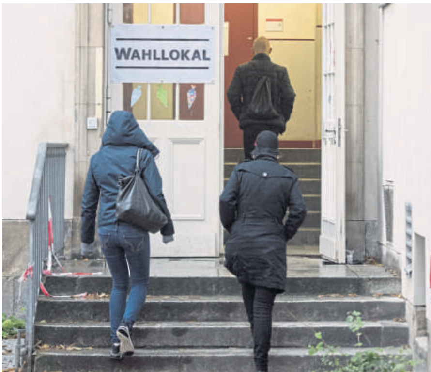
Treppenstufen versperren Rollstuhlfahrern den Zugang zum Wahllokal.
