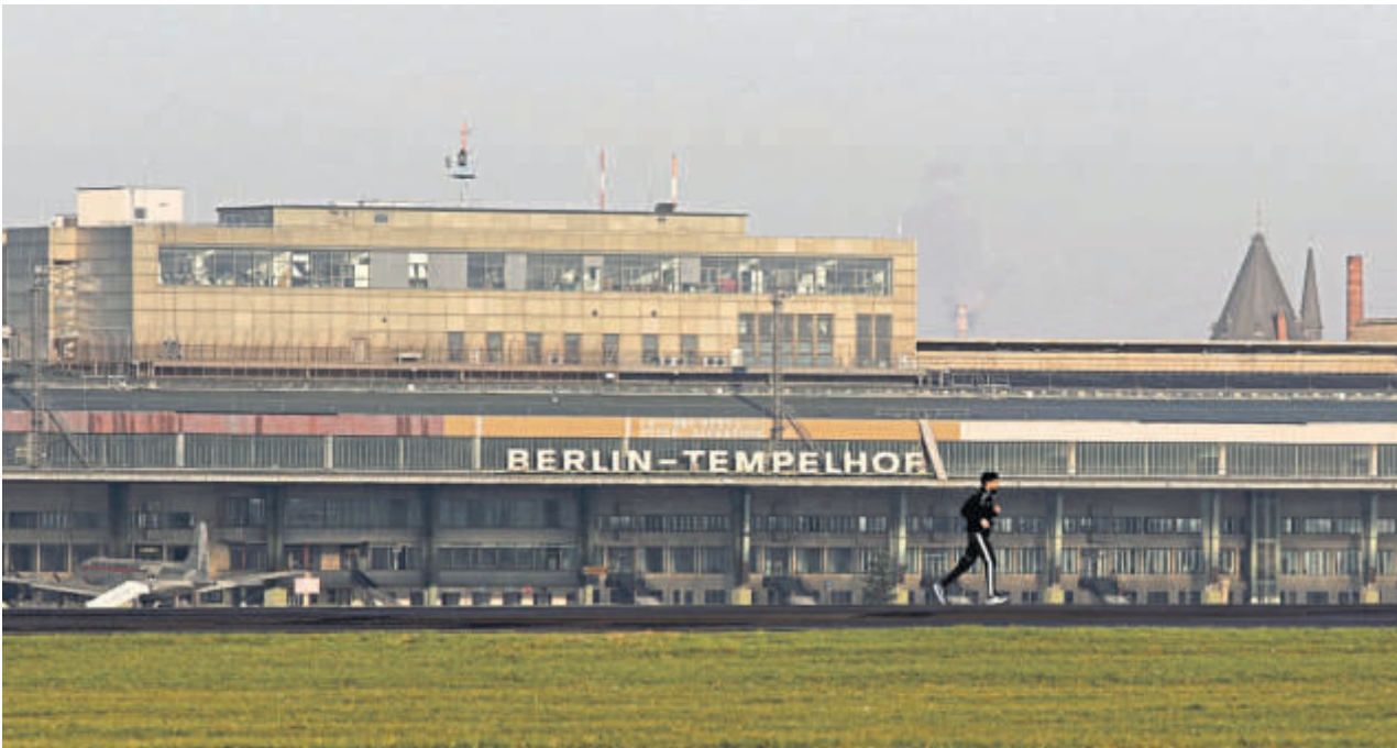
Ob und wann ausreichende Mittel für die Sanierung des ehemaligen Flughafengebäudes zur Verfügung stehen, ist unklar.
