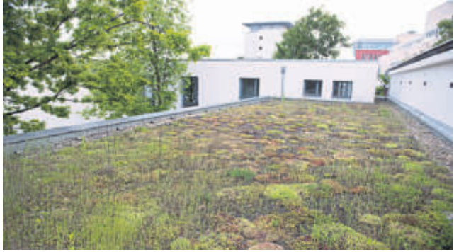
Hilfreich: Grüne Dächer speichern Regenwasser.
