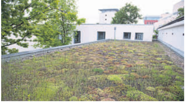
Hilfreich: Grüne Dächer speichern Regenwasser.
