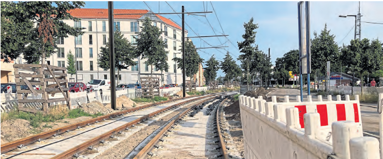
Die Gleise liegen schon: Bald sind Schöneeweide und Adlershof über eine Tramlinie verbunden.
